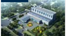
■ Einweihung Erweiterung Fabrik China
